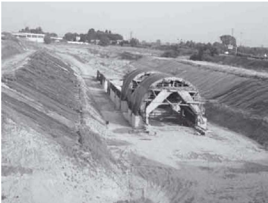
Dopo quasi quattro mesi si torna a lavorare ai cantieri Tav di Somaglia per realizzare la galleria artificiale
